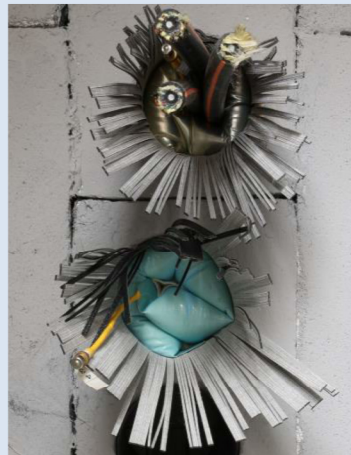
Kabeldurchführung abgedichtet
