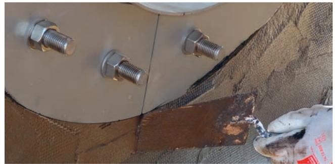
HRD 300-FUF/300 Edelstahlausführung mit Anbindung an KMB mittels Vlies-Zulage, s. Seite 43
