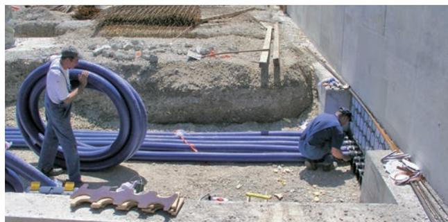
Verlegung Kabeleinführungssystem KES-M 150 mit Manschettentechnik
