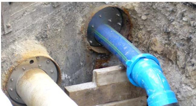
Individuelle Ringraumdichtung in geschlossener oder geteilter Ausführung zur Abdichtung von neu zu installierenden oder bereits verlegten Rohren. Die Dichtung wird entsprechend kundenspezifischer Maßvorgaben gefertigt – zum Beispiel exzentrisch, mit überdeckendem Flansch oder für Mehrfach- und Mischbelegung.
