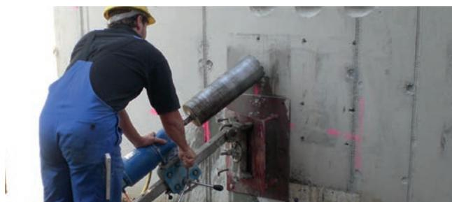
Herstellen von vertikal und horizontal verlaufenden Diamantschrägburungen für die Aufnahme von HRD-Dichteinsätzen
