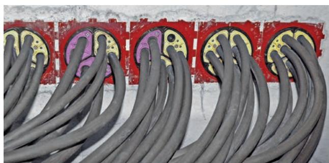
Kabelzug durch HSI-Dichtpackungen mit SEGMENTO-Systemeinsätzen
