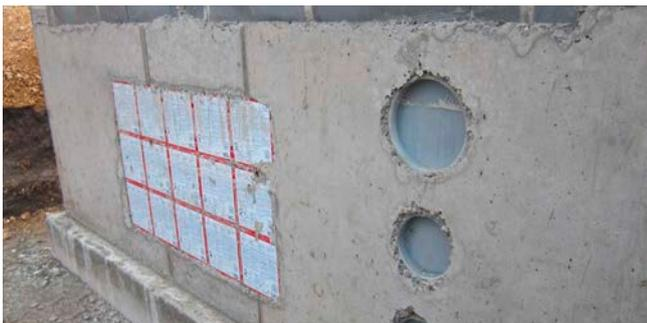
ZVR 150 und ZVR 200 einbetoniert neben HSI 150
