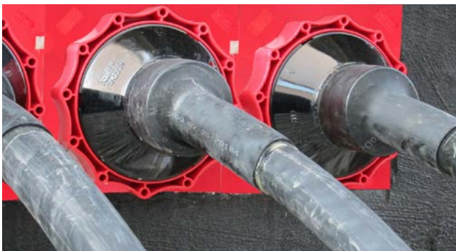
Stationseinführung: Niederspannungskabel abgedichtet mit HSI 150-D1/80
