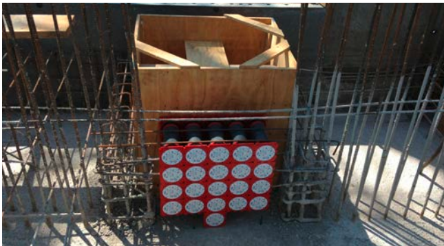
Einbau von Doppeldichtpackung HSI 90-K2 vor dem Betonieren
