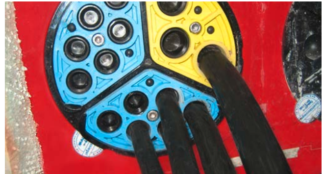
HSI 150 – SEGMENTO – mit integrierter Drehmomentkontrolle und Blindstopfen
