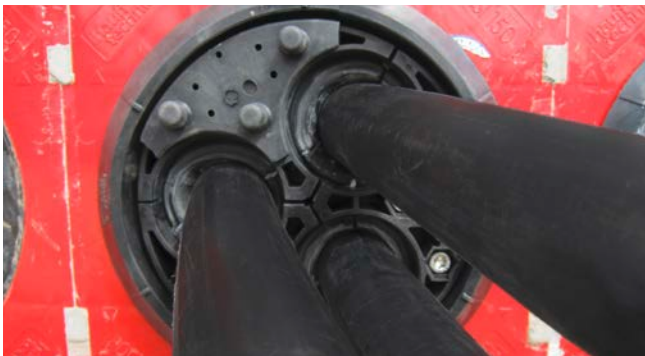
Pressplattenabdeckung HSI 150-PA-3/24-54
