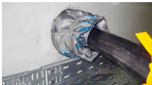
HSS – Einbau in Kernbohrung mit HRD Ringraumdichtungen
