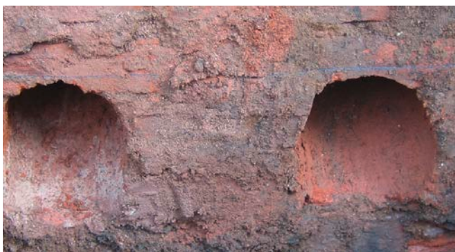
Schräge Kernbohrung in porösem Mauerwerk
