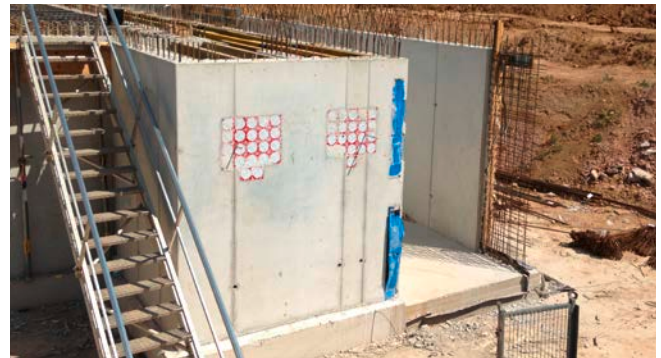
HSI 90-K2 nach dem Betonieren: Hier folgt der Leerrohranschluss
