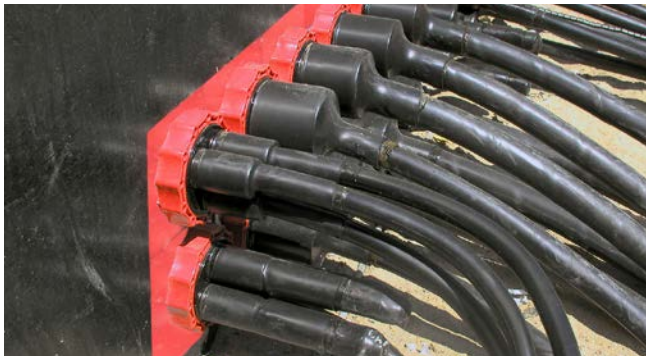
Stationseinführung: Niederspannungskabel abgedichtet mit HSI 90-D1/75 und HSI 90-D3/32
