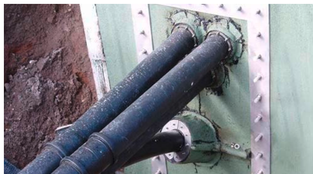
Geteilter Fest-/ Losflansch in Anlehnung an DIN 18533
