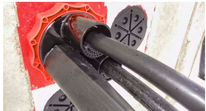
Zentrierband im Systemdeckelstutzen des HSI 150-D3/58
