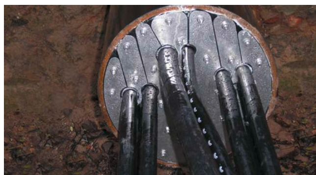
HRD 200-1G in einem Stahlrohr
