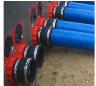
Druckdichter Anschluss an die HSI 150-Dichtpackungen
