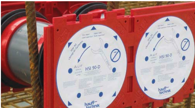
Doppeldichtpackung HSI 90 als Paket in Schalung eingesetzt
