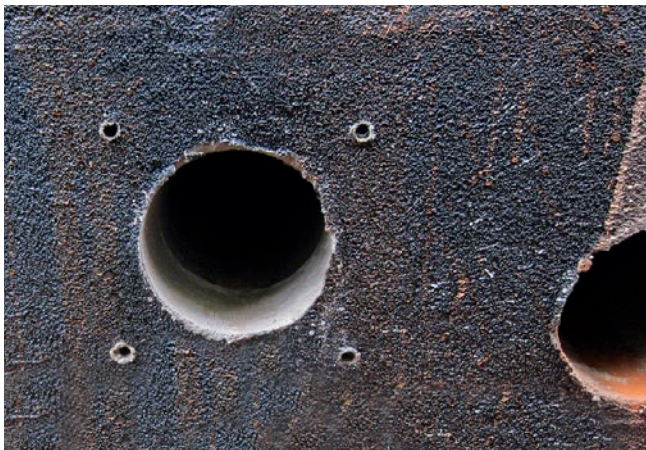
Kernbohrung und Dübellöcher
