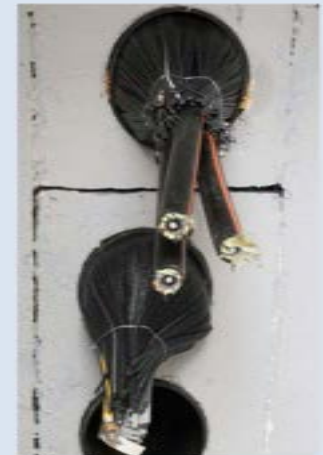
FB-Feuerwiderstandsband mit Bindendraht fixiert
