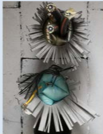
Kabeldurchführung abgedichtet
